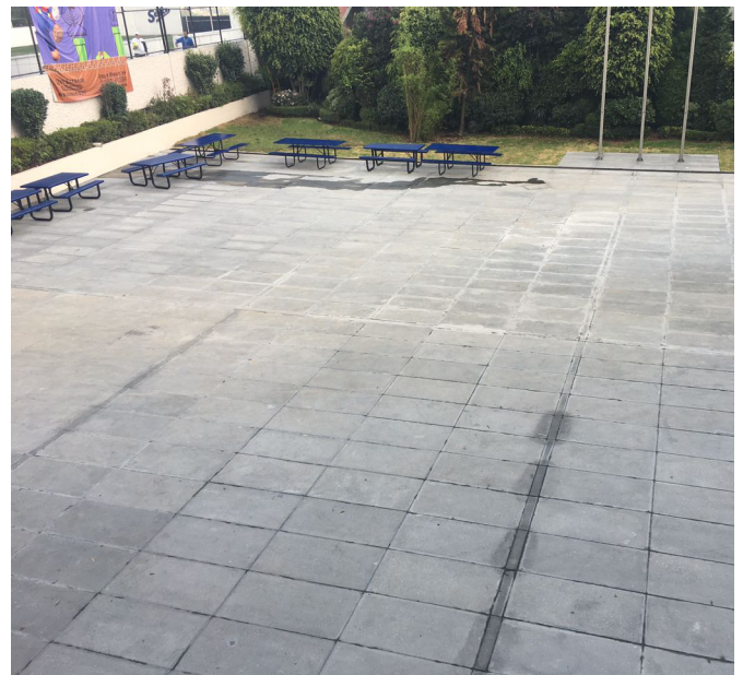
Módulos prefabricados Rocapanel utilizados como losa de piso.
