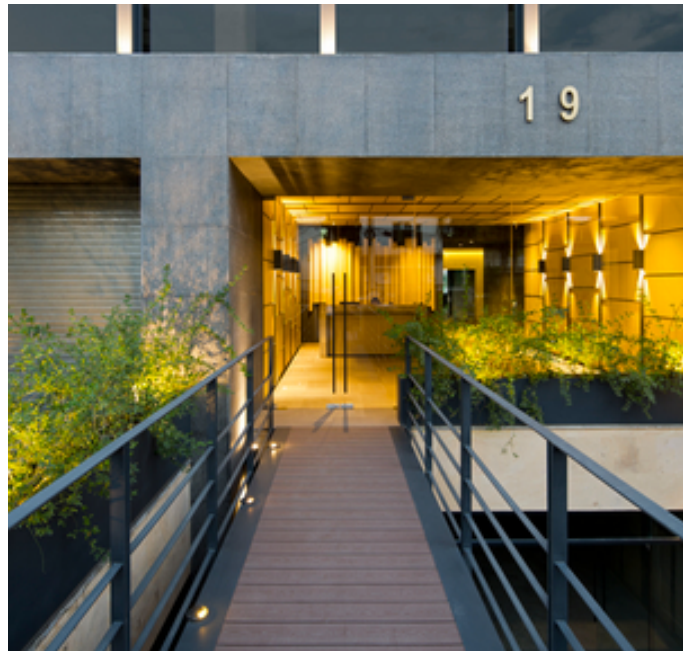
Torre Templanza, se utilizó Rocapanel para los muros y revestimiento de columnas
