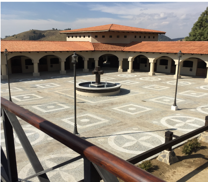
Losas de techo para residencia campestre.
