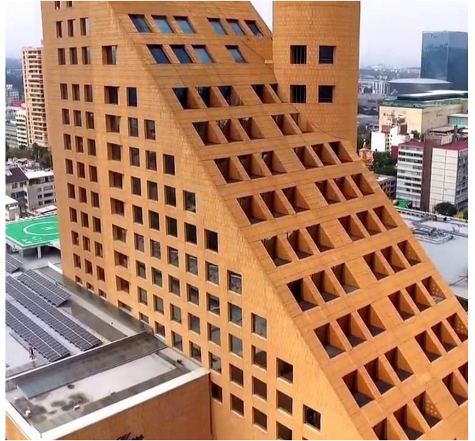
Remodelación de El Palacio de Hierro Moliere, fachada revestida con Rocapanel
