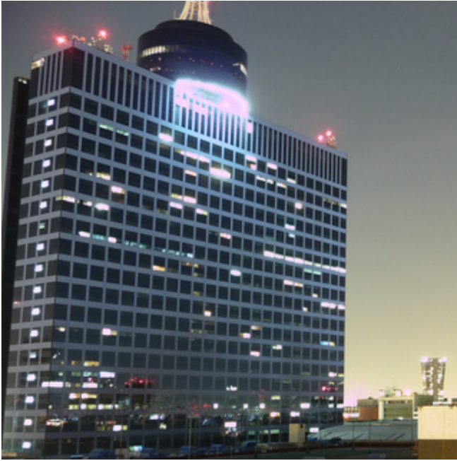
Edificio WTC CDMX Muros anti-fuego, cubos de elevadores y muros divisorios construidos con Rocapanel.
