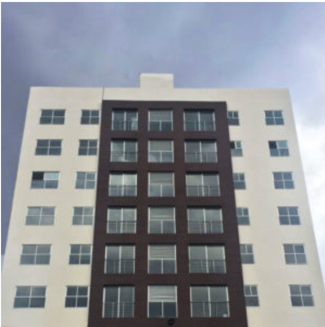
Edificio Cuauhtemoc. Fachada, muros exteriores e interiores fueron construidos con concreto aligerado Rocapanel.
