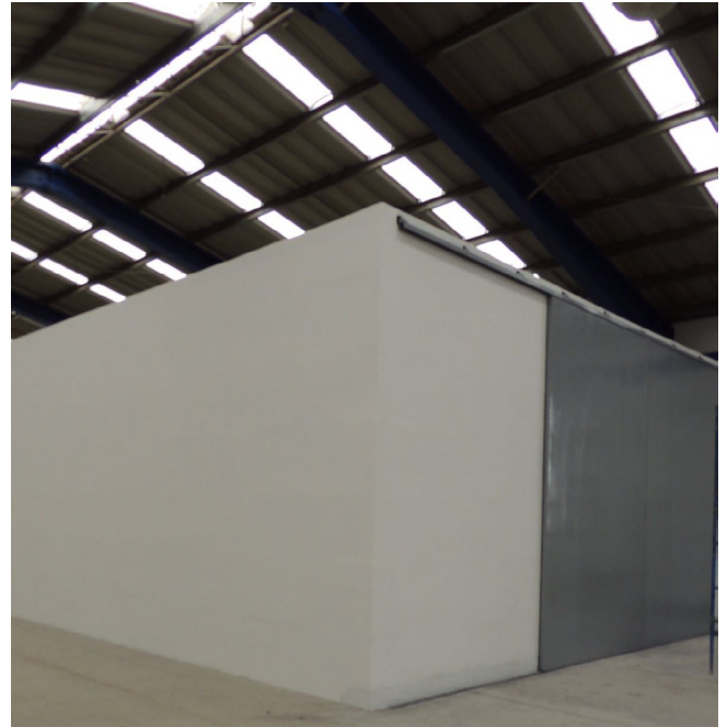
Oficina laboratorio construido dentro de nave industrial
